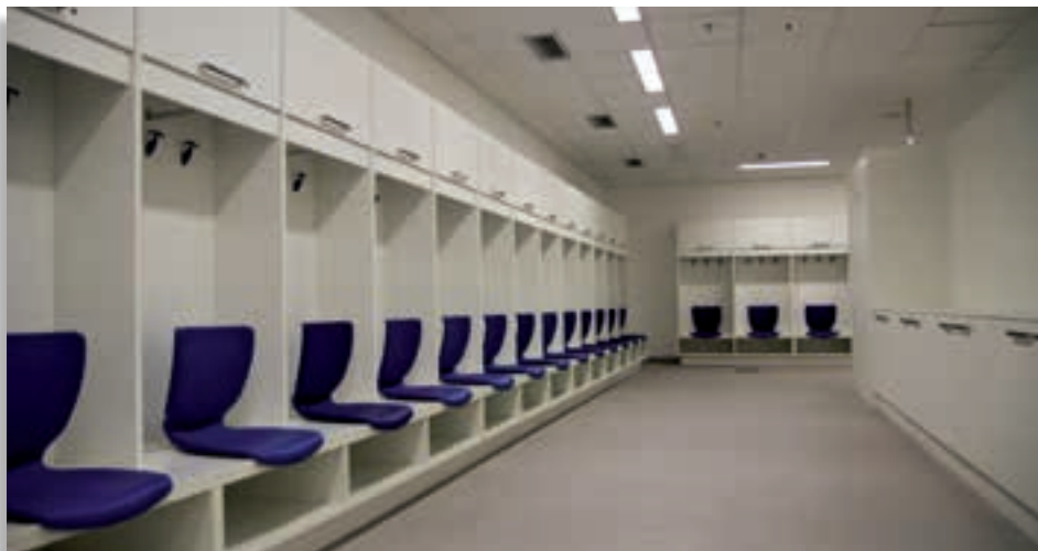
Embutidos no forro, com difusor em acrílico leitoso, equipados com T5 de 25W a 4000K, iluminam vestiários dos atletas.
