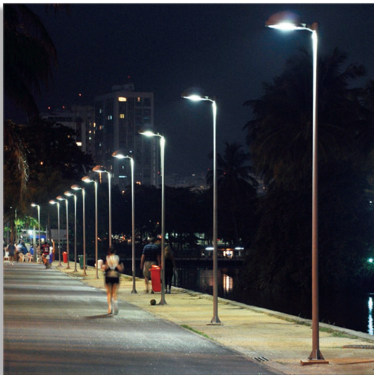
Lagoa Rodrigo de Freitas: retrofit de iluminação pública, substituindo lâmpadas de vapor de sódio por LEDs. (Publicado na edição nº 56 da Revista Lume Arquitetura)
