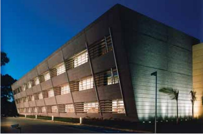
A fachada principal do edifício novo recebeu iluminação direta homogênea, através de postes na frente do estacionamento, com luminárias de fecho assimétrico.
