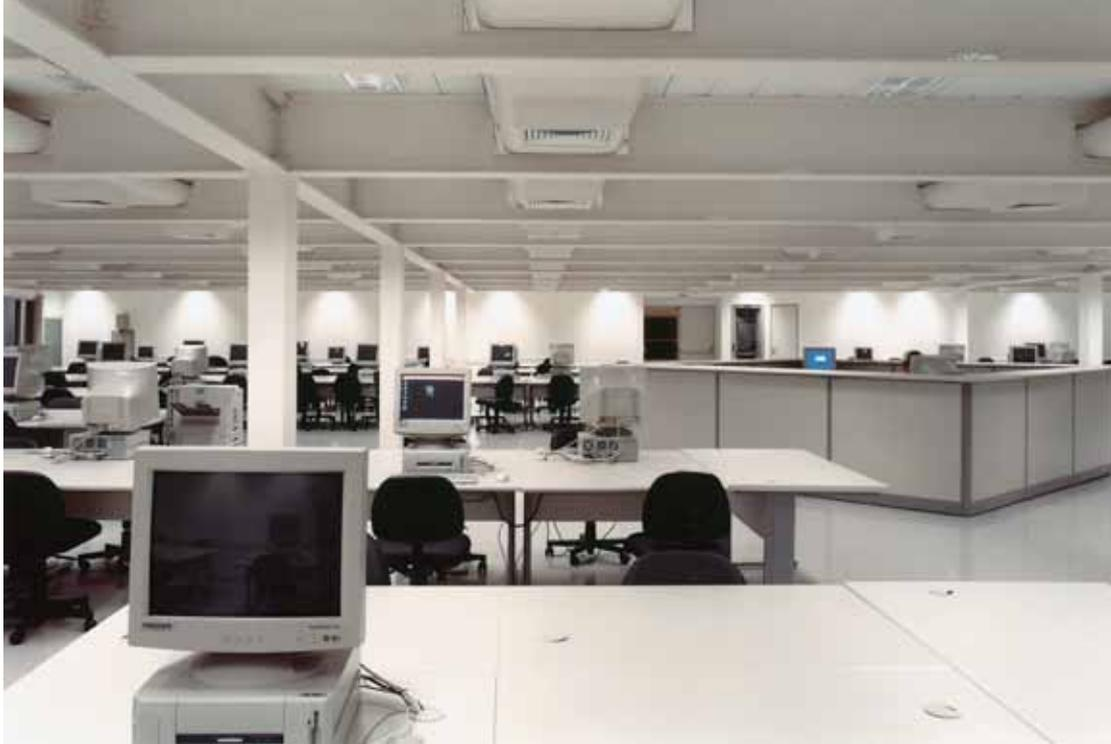
No laboratório de Computação Gráfica, onde a reprodução de cores é atributo muito importante, há iluminação geral com fluorescentes aliada a um sistema dimerizado com reatores especiais.
