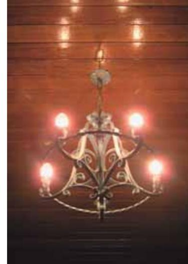
seria preciso uma reforma total da rede elétrica e que lâmpadas incandescentes de potências altas seriam substituídas por lâmpadas de descarga, como as de multivapores metálicos, usadas na área externa, tanto nas arandelas, quanto nos postes, na potência de 70W. O uso de incandescentes foi mantido apenas para o interior da residência e da igreja, com potência de 40W.
