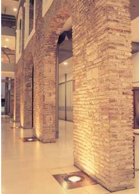
das lojas, assim como valorização das arcadas de tijolos pelo contraste de intensidade e cor, pois estão iluminadas com lâmpadas vapor de sódio com efeitos *wall wash*.
