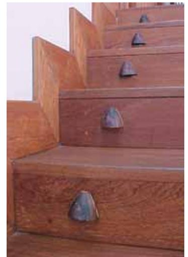
A iluminação indireta foi pontuada com luminárias de eucalipto que remetem a fungos brotando do tronco de árvores. A lâmpada usada foi uma halógena de 100W com dimmer.
