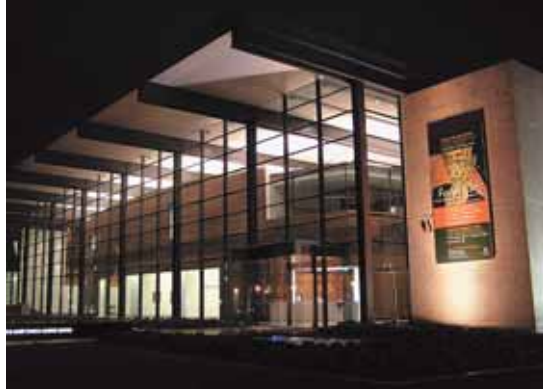
A parede externa na qual fica afixado um cartaz é iluminada em “ uplight ”, com lâmpada de vapor metálico de 70W, em luminária embutida no solo.
