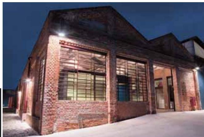
A edificação do início do século XX teve os revestimentos de suas paredes removidos, deixando os tijolos originais aparentes.
