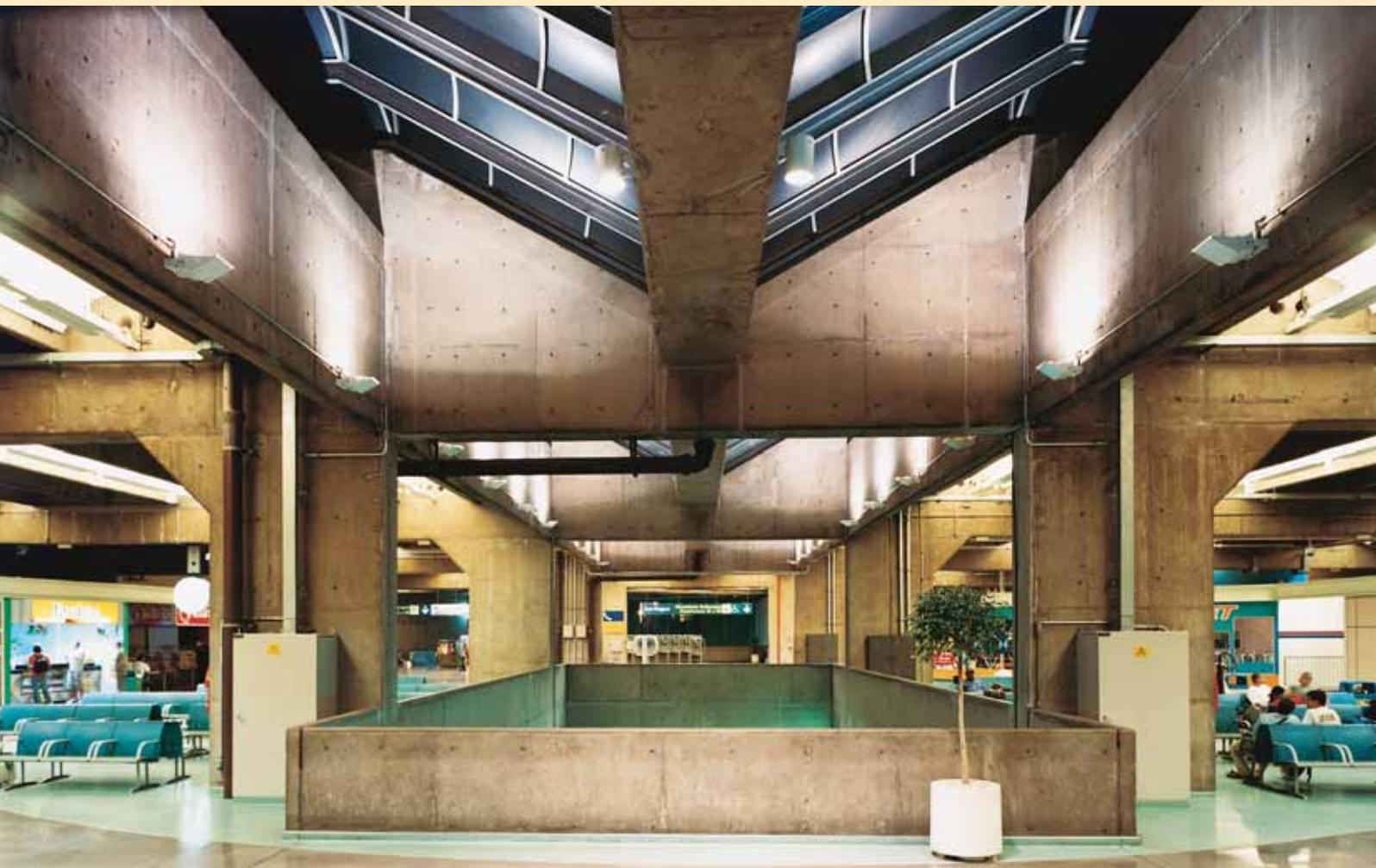
Mezanino – clarabóias / vazio sobre plataformas de embarque: Iluminação indireta (vapor metálico) – bandejas de facho assimétrico iluminam a cobertura de policarbonato.
