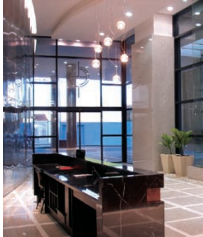
A iluminação do interior da recepção do edifício é feita basicamente com lâmpadas de vapor metálico PAR 30 e incandescentes 40W
