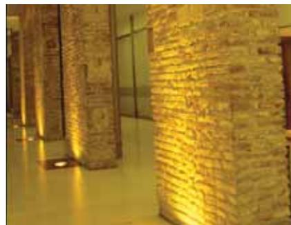
**Banho de Luz (wall-wash):** destaca-se uma superfície com um banho de luz e a textura da parede é ressaltada, criando um foco de atenção dentro do espaço. Diversos objetos na parede podem ser iluminados com uniformidade e a superfície se transforma em uma fonte secundária de luz. Um efeito interessante é a combinação do banho de luz com a luz de destaque, criando no espaço três níveis bem diferenciados de iluminação: o do ambiente, o da superfície e o do destaque.
