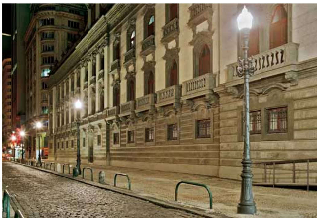
Na fachada lateral, projeto também contempla a via estreita, com o aproveitamento dos cinco postes de ferro fundido, presentes na calçada.
