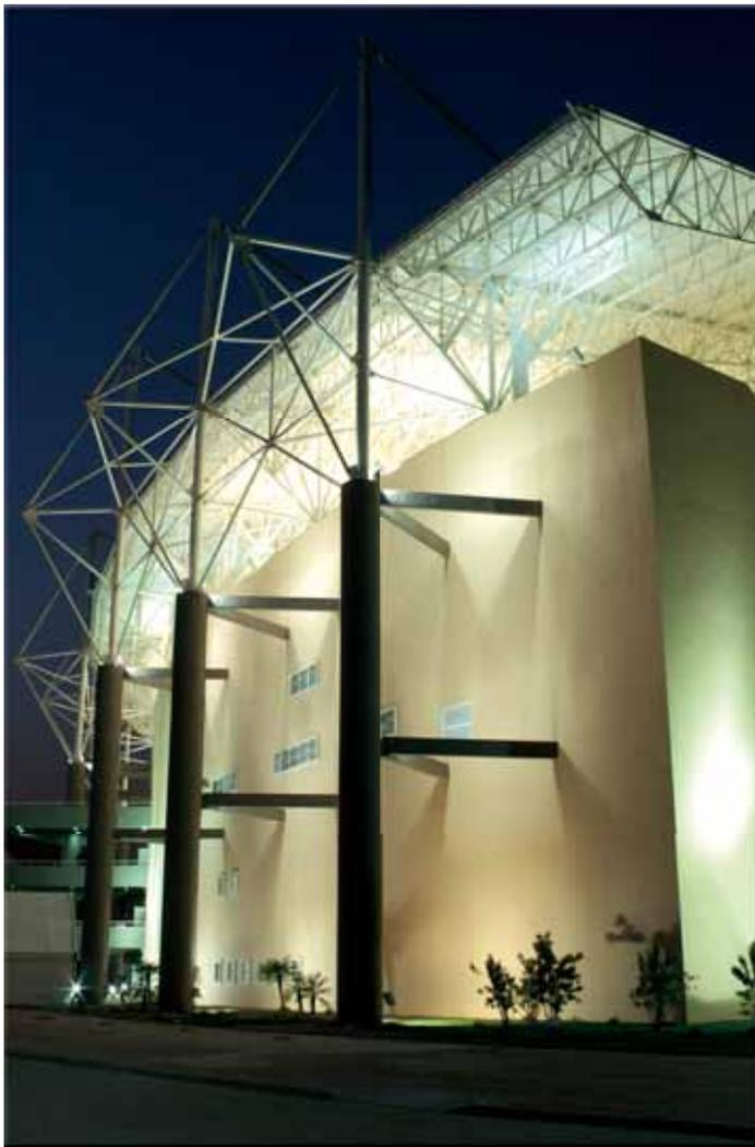
Pilares de sustentação da cobertura com projetores de iluminação em montagem tipo "jaboticaba".
