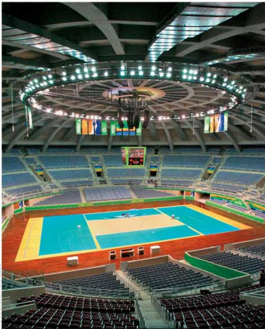
Maracanãzinho: vista geral com passarela metálica, leito da cablagem de alimentação elétrica e fixação dos projetores para as áreas de jogo e arquibancadas e cadeiras.
