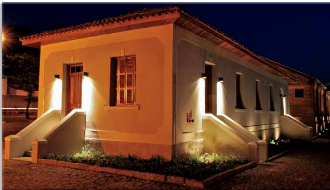
Arandelas com lâmpadas fluorescentes balizaram as escadas no prédio de serviços.
