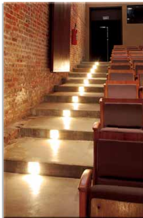
Balizadores com lâmpadas halógenas foram instalados nas escadas do auditório.
