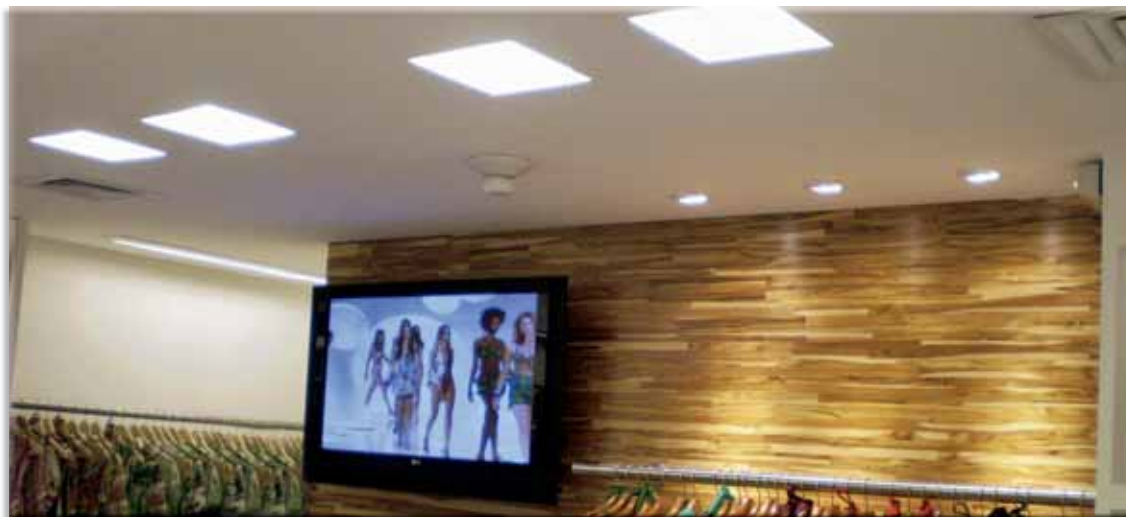
Luminárias com difusores em vidro translúcido oferecem luz tênue e sem reflexos.
