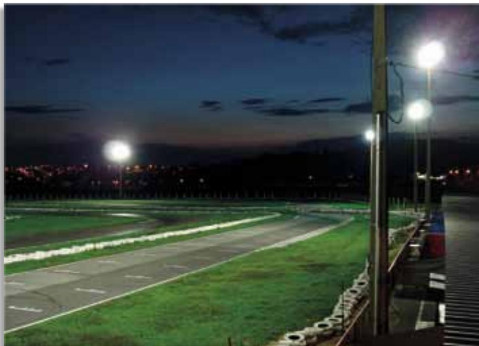
Para a nova iluminação do Kartódromo de Betim foram utilizados 14 postes de concreto do tipo duplo T e 41 projetores de fecho simétrico.
