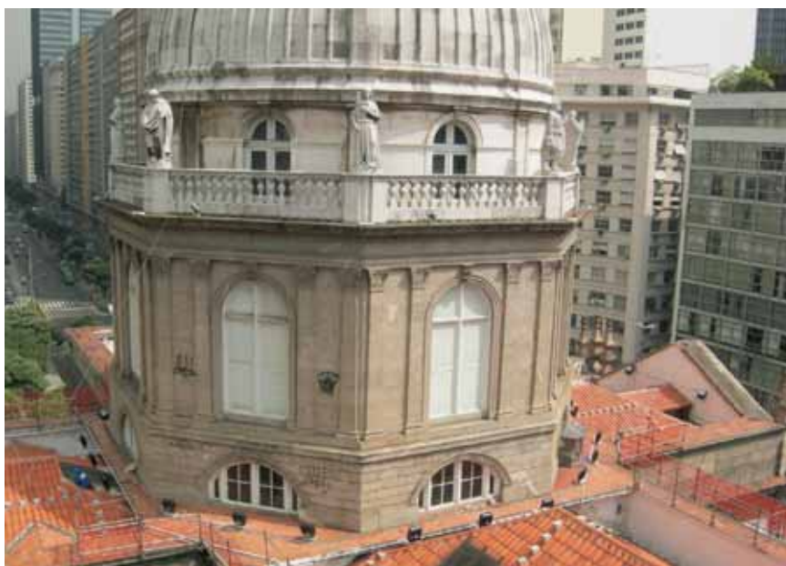
Equipamentos instalados sobre telhado para iluminação da base da cúpula.
