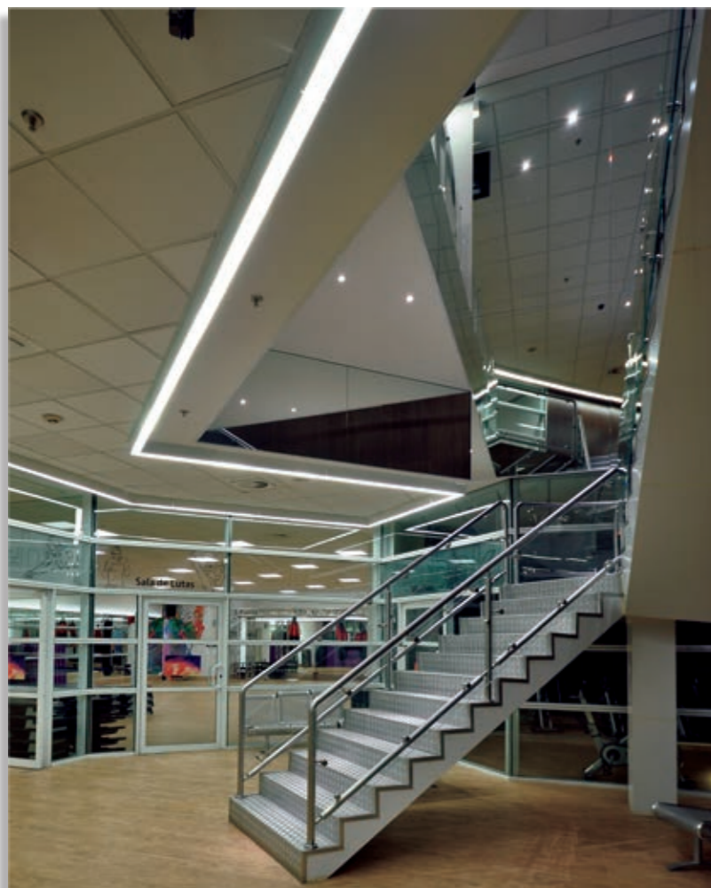
Acima e abaixo, área de ginástica e corredores de circulação da Reebok Sports Club Vila Olímpia com sistema de linhas contínuas equipado com luminárias sobrepostas e T5 de 28W a 3000K.
