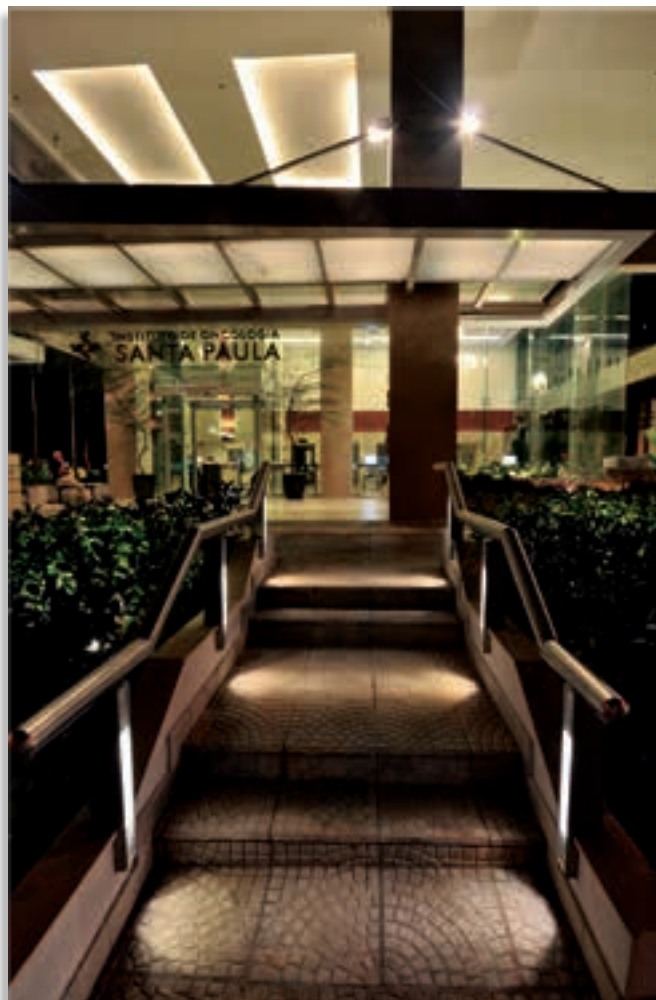
Na foto maior, marquise com fechamento em vidro leitoso iluminada internamente por barras de LED de 24W a 4000K para luz difusa. Na foto menor, balizadores embutidos no piso com LED de 3W/25° iluminam o acesso nos jardins externos.
