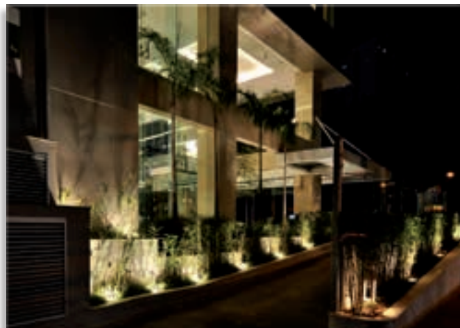
Na foto maior, marquise com fechamento em vidro leitoso iluminada internamente por barras de LED de 24W a 4000K para luz difusa. Na foto menor, balizadores embutidos no piso com LED de 3W/25° iluminam o acesso nos jardins externos.
