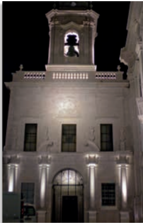
Igreja e convento da Graça, situados no topo de uma das colinas de Lisboa, antes e depois da realização do restauro e do projeto de iluminação.
