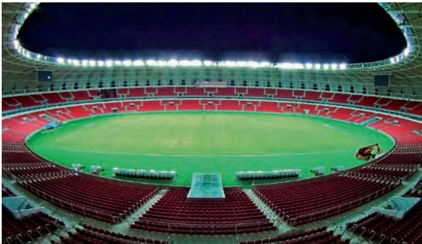
Campo de jogo com 104 projetores de IP 65, com cinco fotometrias diferentes e lâmpadas de vapor metálico de 2000W para atingir os níveis de iluminância exigidos pela FIFA.
