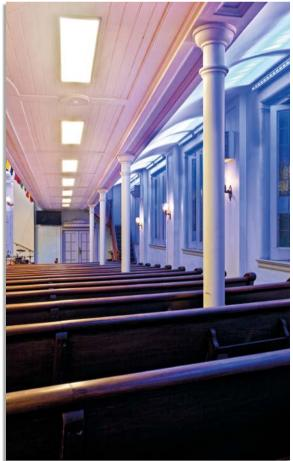
Luminárias LED circulares de 192W a 4000K, no teto, proporcionam 13 mil lumens para iluminação geral.
