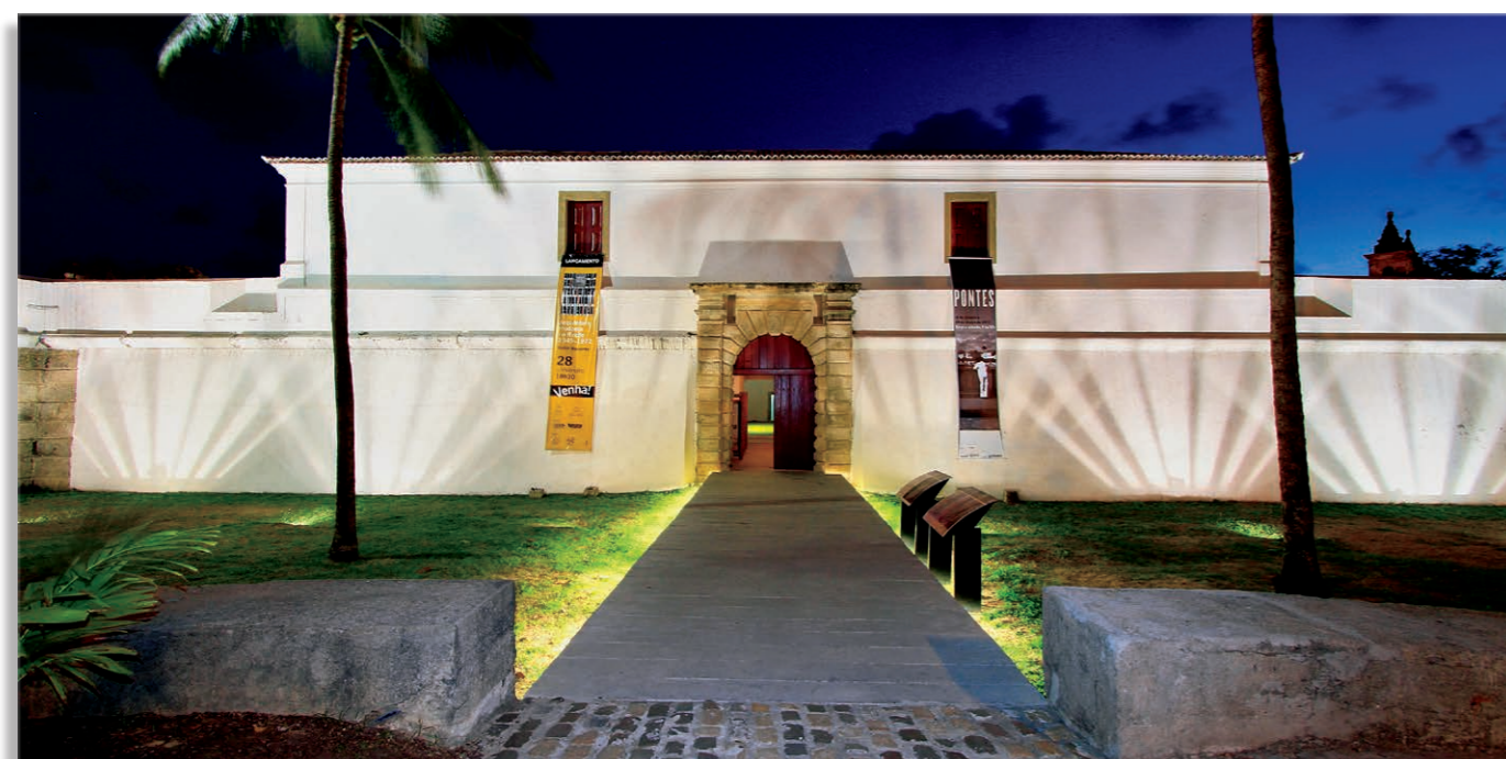
Passarela de acesso ao Forte recebeu, em sua parte de baixo, luminárias herméticas com fluorescente tubular T5 de 28W a 5000K.
