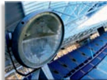
A iluminação do campo da Arena do Grêmio contou com 410 projetores equipados com lâmpadas de vapor metálico de 2000W, cada, a 5600K e com IRC 90.
