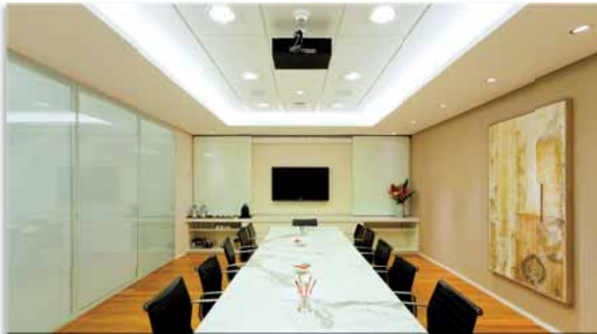
Luminárias cilíndricas com fluorescentes compactas duplas e embutidos com lâmpadas PAR 20 fazem a iluminação da grande sala de reunião.
