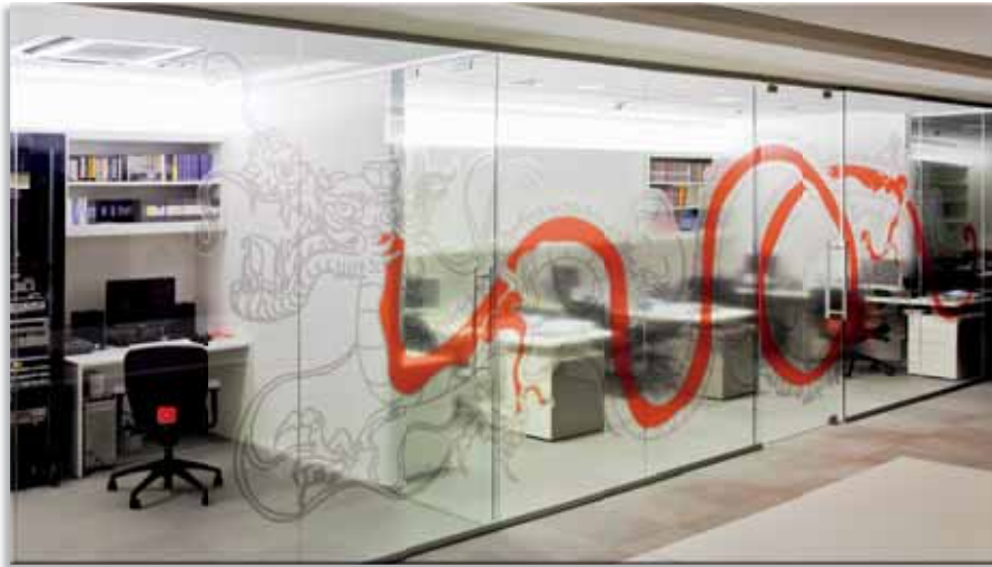
Iluminação da sala de apoio com lâmpadas fluorescentes instaladas em montagens sobre os armários e embutidos.
